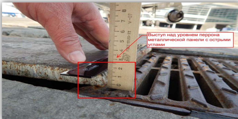
Фото 4. Место пересечения дренажной системы и бетонных плит
